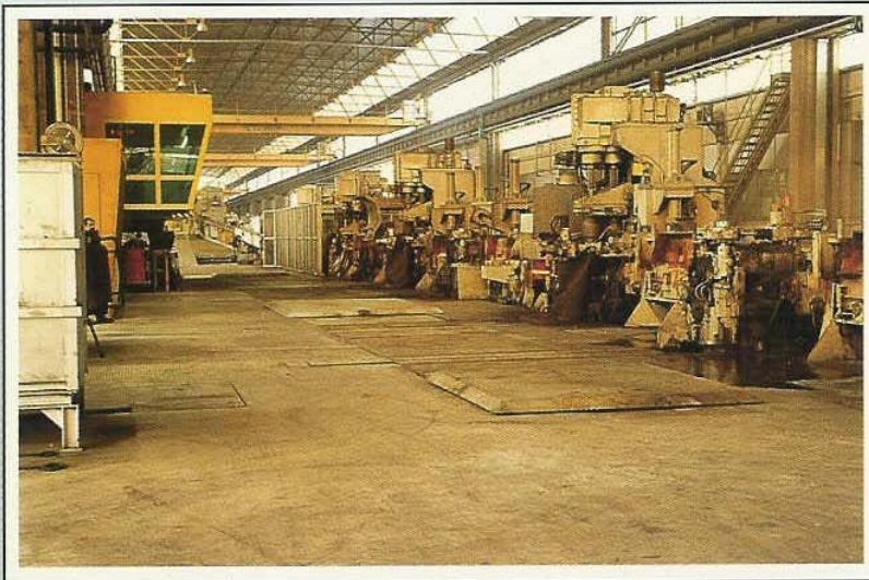
Valbruna hot rolling mill
